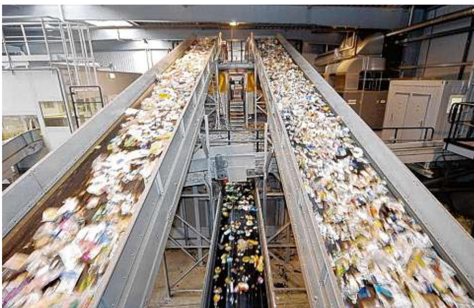
Labyrinth aus Förderbändern: Die Sortieranlage läuft fast rund um die Uhr.
