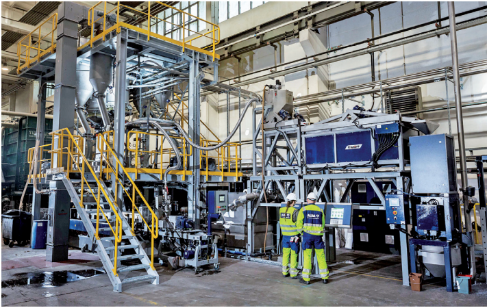
Seit einem knappen Jahr steht in Eisenhüttenstadt das Kaskaden-Extrusionssystem Corema mit einer Leistung von bis zu 1,4 t/h, bestehend aus Erema-Recyclinganlage und Coperion-Doppelschneckenextruder.
